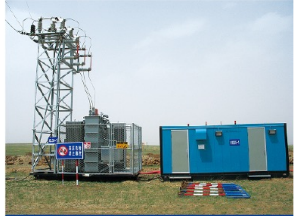
5MVA-35kV/6kV移动变电站
